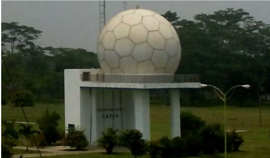
Gambar 3. Antena Sea Space 6.1 meter di Stasiun Bumi Rumpin
